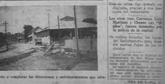
Distintos aspectos de las obras que se realizan en Puerto Limón para la construcción de los baños, las cuales tendrán a completar las diversiones y entretenimientos que ofrece aquí punto al turista. — (Fotos cortadas de don Rodolfo Vargas).
